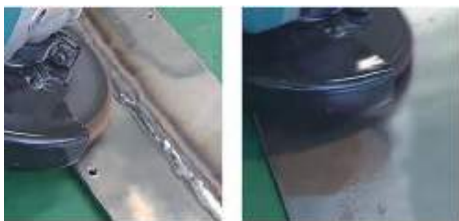
Limpeza em cordões de soldadura
